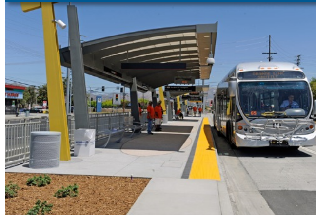
LA MTA, LA Orange Line, Los Angeles, CA
